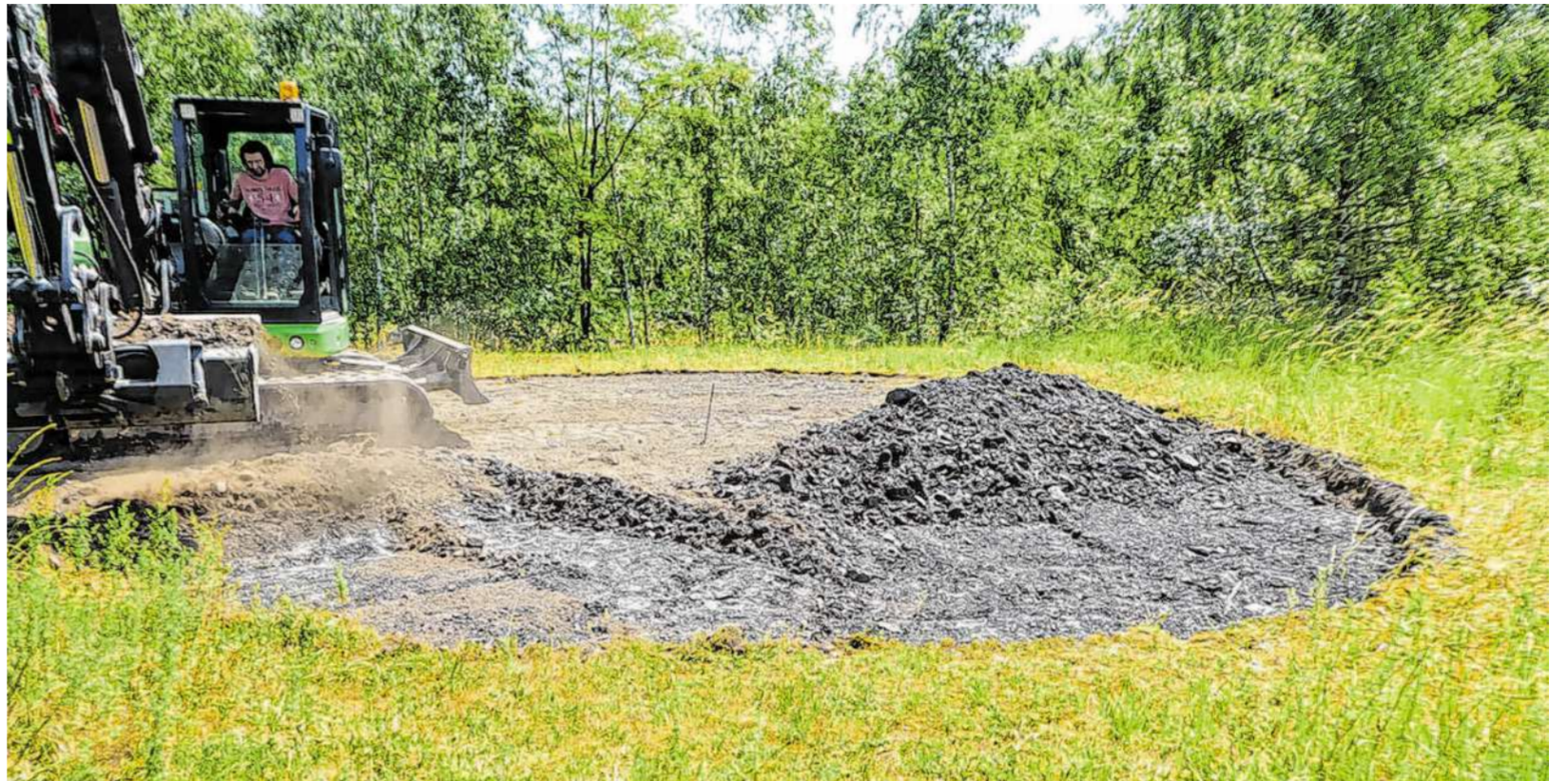
Ein Bagger trägt Erdreich ab: Geschickt modelliert der Fahrer mit der Schaufel das Profil eines Kleingewässers.
